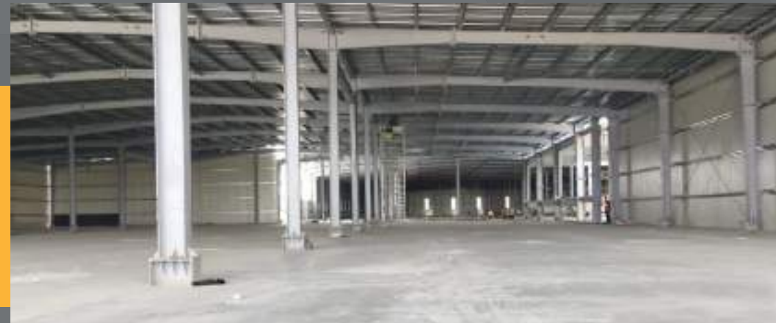
First Floor Production : 25 M * 8 Grid : Floor Load : 1.75 MT / Sqm ( Point Load ) Height : 6 M +
